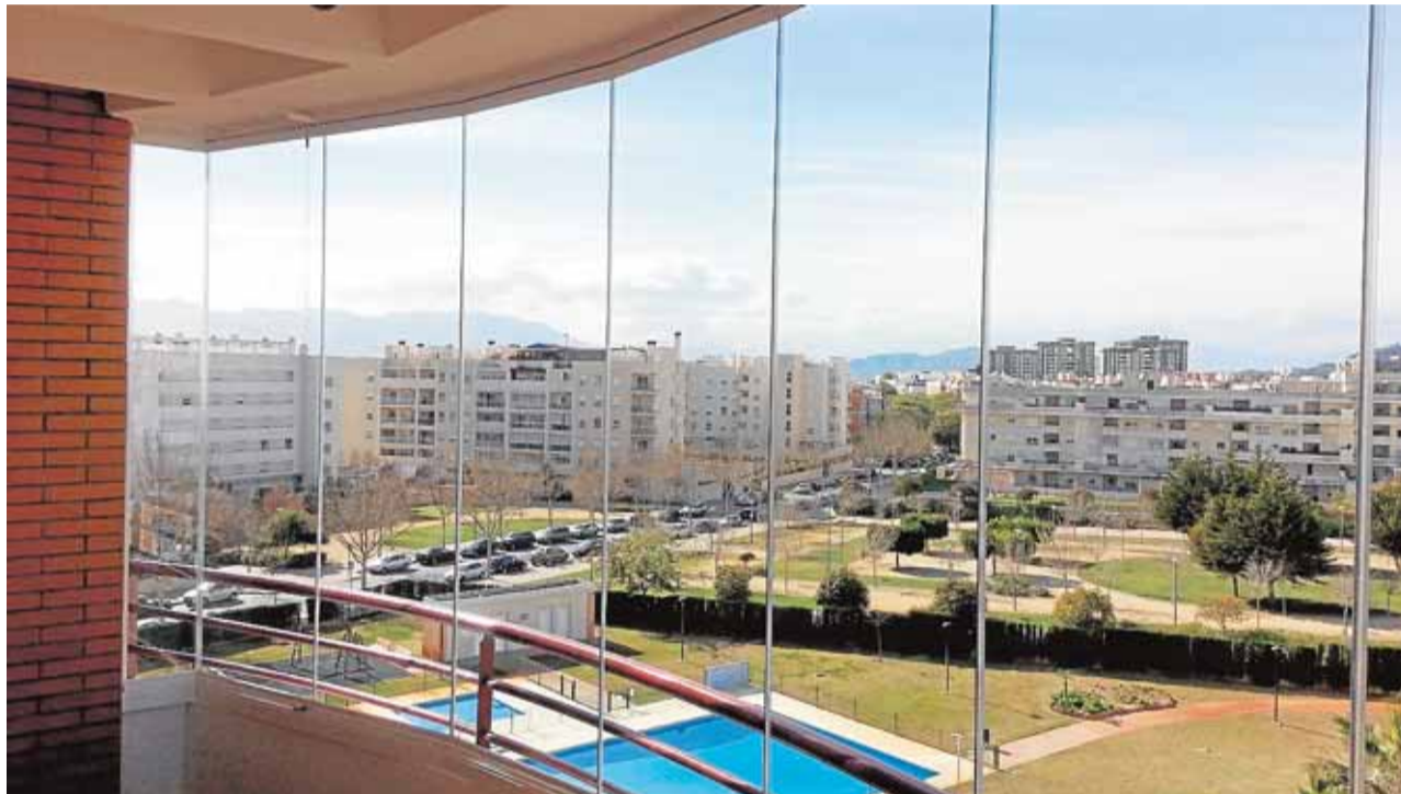
Uno de los sistemas de cerramiento de TodoCristal, instalado en una vivienda en Málaga. :: SUR
